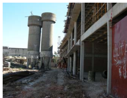
Foto N° 7 y 8: Obra Nueva. Escuela de Danzas Fonrouge 711 / 35
