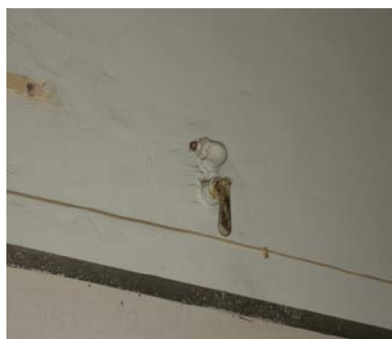
Foto N° 5 y 6: Instalación de Gas. Lacarra 621
